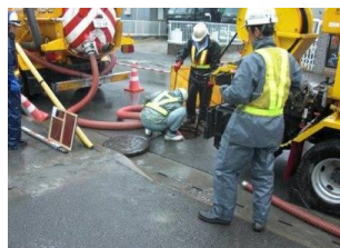
清掃車による土砂吸入作業
