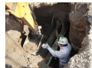
躯体のずれによる道路陥没応急復旧状
