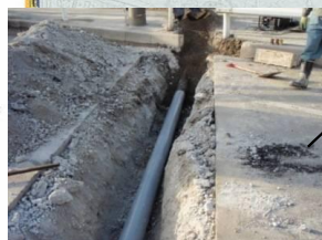
応急的なバイパス管設置
