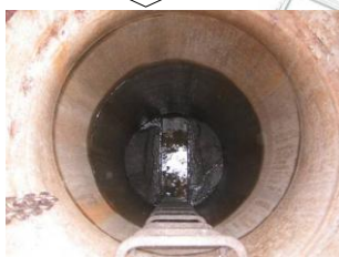
ポンプ設置による応急処置状況
