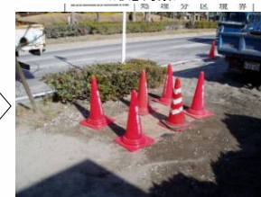
マンホール撤去後の安全対策状況
