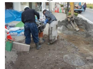
道路陥没応急復旧後
